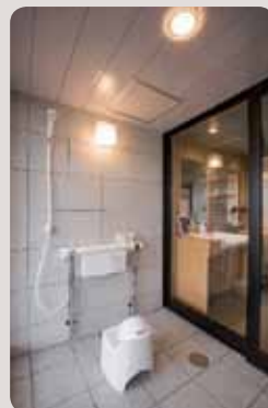
▲⑥201号室のユニバーサルシャワーブース
